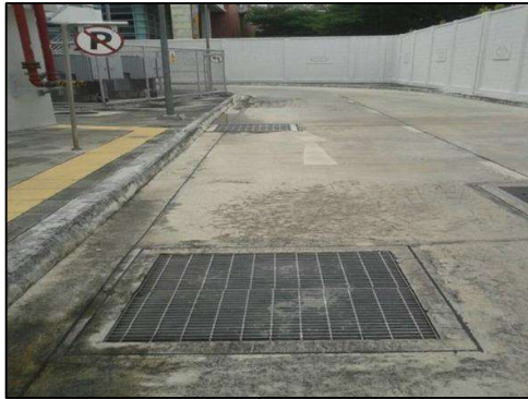
รูปที่ 2-23 (ต่อ) ระบบระบายน้ำและการทำความสะอาดบริเวณอาคารจอดแล้วจร
