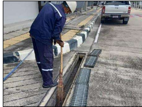
รูปที่ 2-23 (ต่อ) ระบบระบายน้ำและการทำความสะอาดบริเวณอาคารจอดแล้วจร
